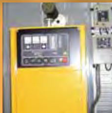
Пульт управления ДГУ и автоматический коммутатор нагрузки
