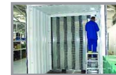
Система разделения воздушного потока на выходе из контейнера
